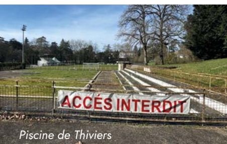
Route du Poteau des Landes
